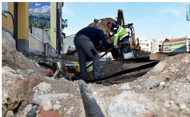
DAS VERLEGEN VON STROMLEITUNGEN gehört zu den Aufgaben der Stadtwerke Mitarbeiter...
